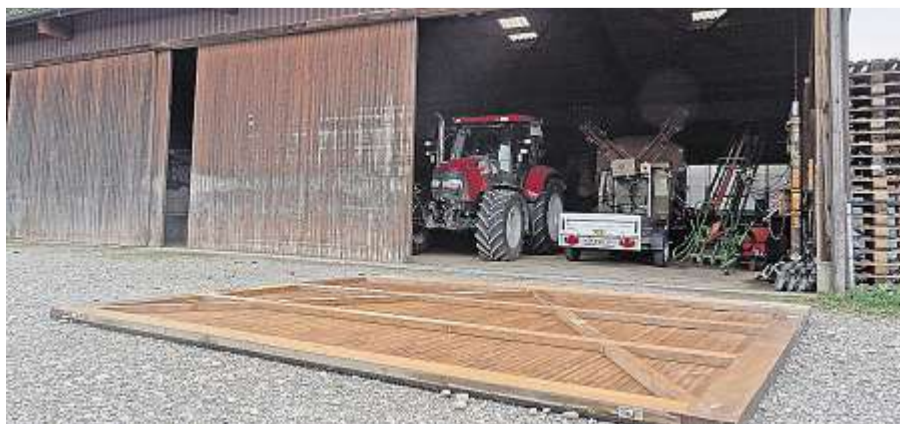
Das Scheuentor hat der Sturm einfach aus der Halterung gelöst.
