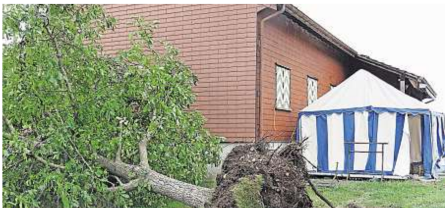
Am Schützenhaus entstand ein Schaden von rund 7000 Franken.
